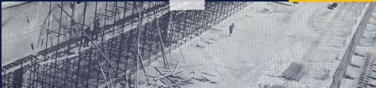
Mi-juillet... les poteaux délimitent le hall de fabrication et la construction de la poutre caisson avance à grands pas.
